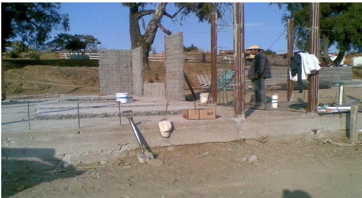
Foto 2.- Se observa el castillo tubular de acero, colado en el interior de Concreto y los Paneles de 1.22 m. x 2.44 m.
