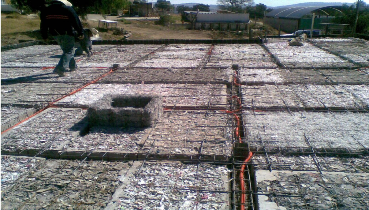
Foto 3. Losa de Panel Ecológico, estructura con castillos tubulares colados con concreto.
